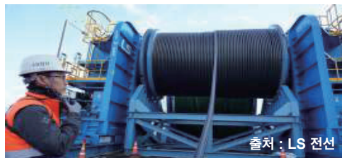
북당진-고덕 구간에 설치 중인 HVDC 케이블
